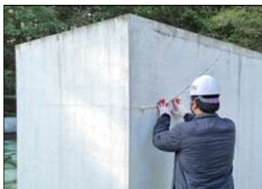
구조물 균열 점검
